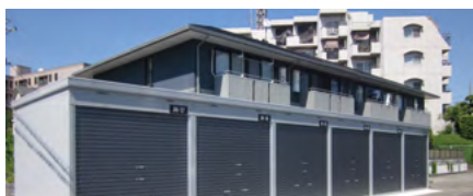
バイクガレージ併設駐車場（左：兵庫県西宮市、右：大阪市此花区）
