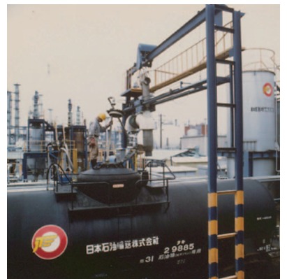
タンク車内洗浄作業(川崎メンテナンスステーション)
