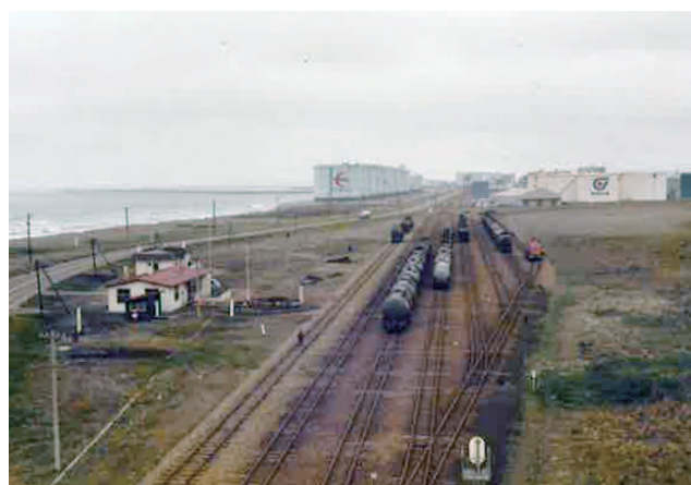
苫小牧港石油埠頭 (1969年)
