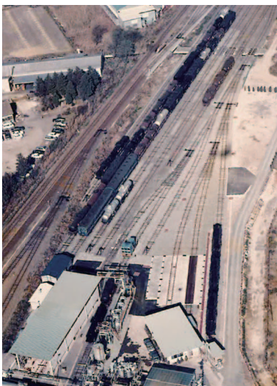
郡山ヤードの全景
