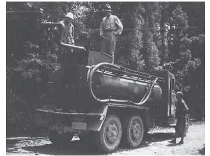
原油積み込み作業中のタンクローリー (創業当時)
