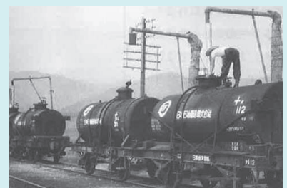
上部に手摺りが設置される前のタンク車への原油積み込み作業(秋田・八森油田にて)
