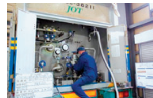
LNGコンテナの容器再検査
