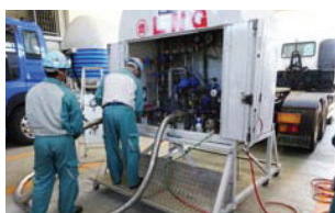
荷卸訓練立会い エネックス石狩営業所
