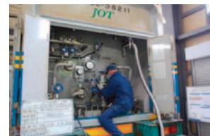
LNGコンテナの容器再検査
