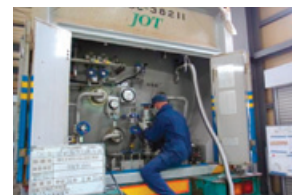
LNGコンテナの容器再検査
