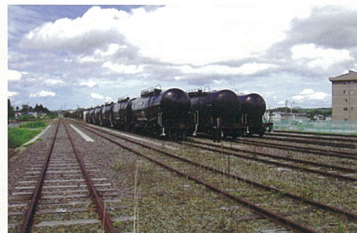
<施工前のタンク車留置施設>
