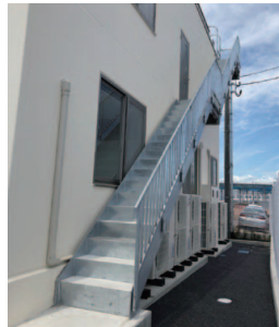
事務所棟裏の外階段
