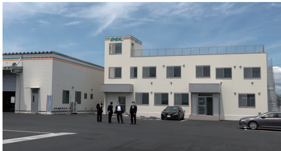
東北支店事務所棟
