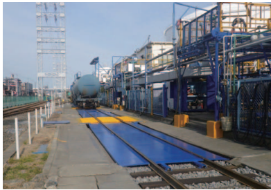
洗浄ピットのリニューアル(2014年)
