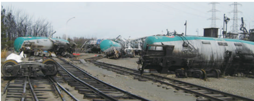
津波の被害を受けた仙台製油所内のタンク車積場
