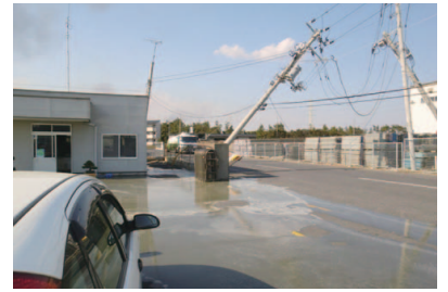
液状化に見舞われた旧鹿島営業所
