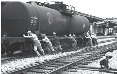
脱線したタンク車の復旧作業(日本石油新潟製油所構内)
