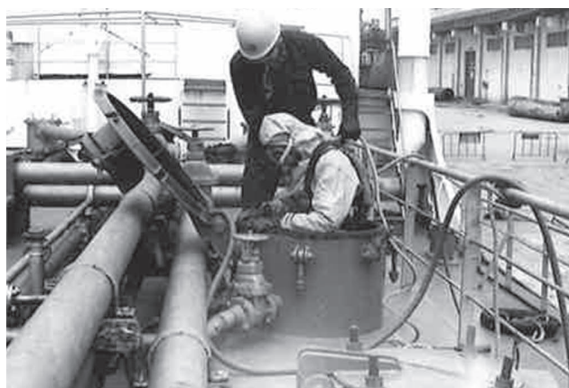
メタノールの船積みに伴う船内洗浄作業
