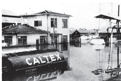
伊勢湾台風で被害を受けた名古屋出張所構内
